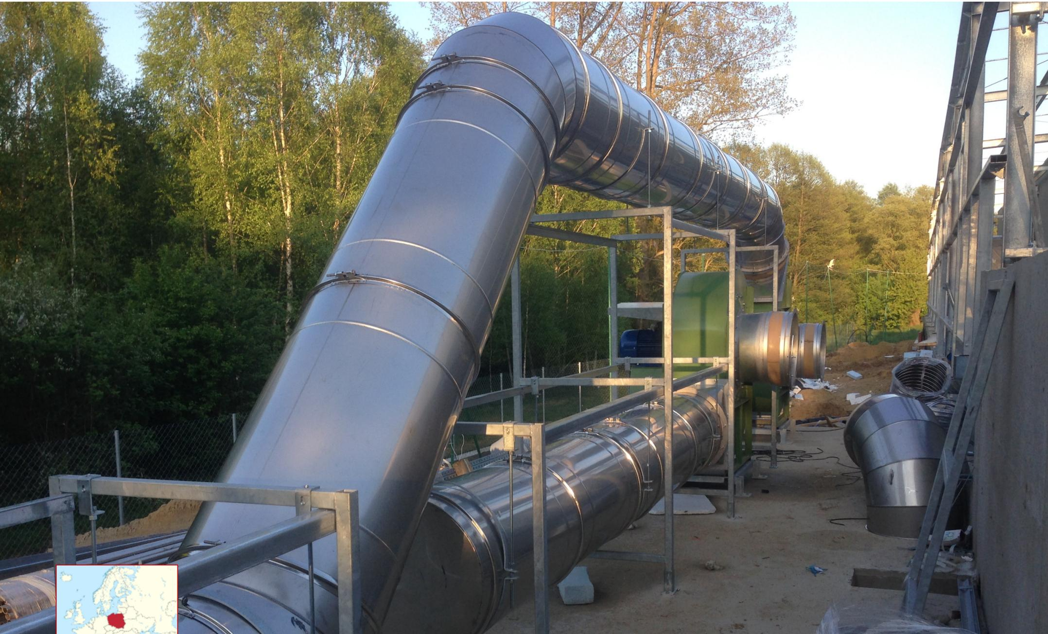
L'IMPIANTO MBT DI SIEDLCE, IN POLONIA, UTILIZZA IL **SISTEMA DI AERAZIONE FORZATA ENTSORGA**. CUORE DEL PROCESSO DI BIOSTABILIZZAZIONE, IL **SISTEMA PERMETTE DI ACCELERARE IN MODO CONTROLLATO ED EFFICIENTE LA REAZIONE**, PER OTTENERE UN **RIFIUTO STABILE**, A BASSISSIMO CONTENUTO DI UMIDITÀ, ADATTO AL CONFERIMENTO IN DISCARICA SECONDO I TERMINI DI LEGGE.
